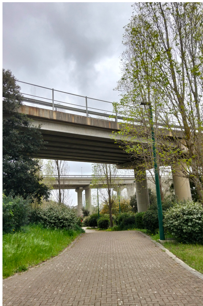
Il Parco al di sotto della Strada per Pitacchi e della Strada Statale 16 bis
